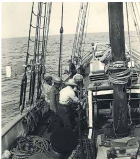
Optagningsarbejde i Storebælt sommeren 1912. På Esthers krøppelspil er monteret optagnings- og udlægningsmaskinen med udveksling og bremse på tromlen. Agterude ses kokken i færd med at hale en pøs vand op.
