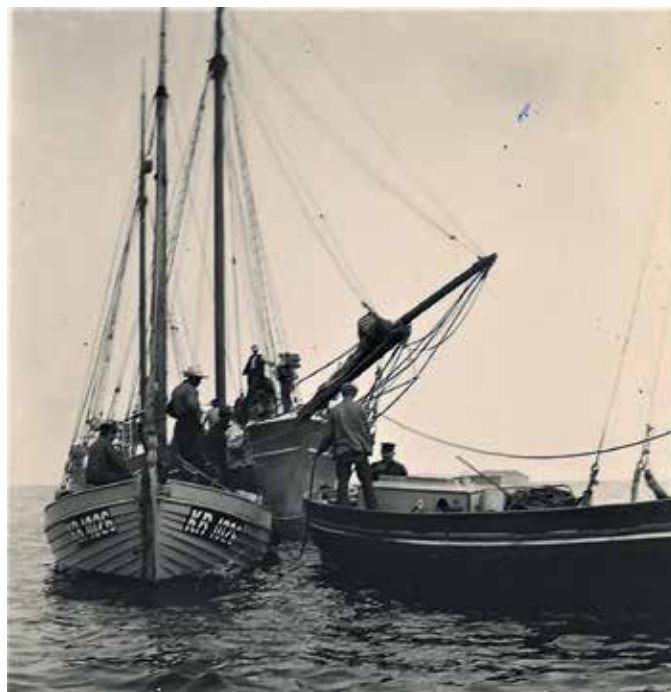
Esther under kabelreparation i Storebælt slæbes af mindre motorbåde. Skipper Sørensen på bakken.
