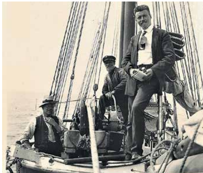
Udlægning af kabel i Storebælt i 1912 med "udlægningsmaskinen". Skipper Martin Sørensen til venstre, Korsør-lods Kruse i midten og ingeniør Agersted til højre.
